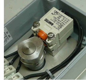
Bartec-Endschalter: mechn. druckfest gekapselt
